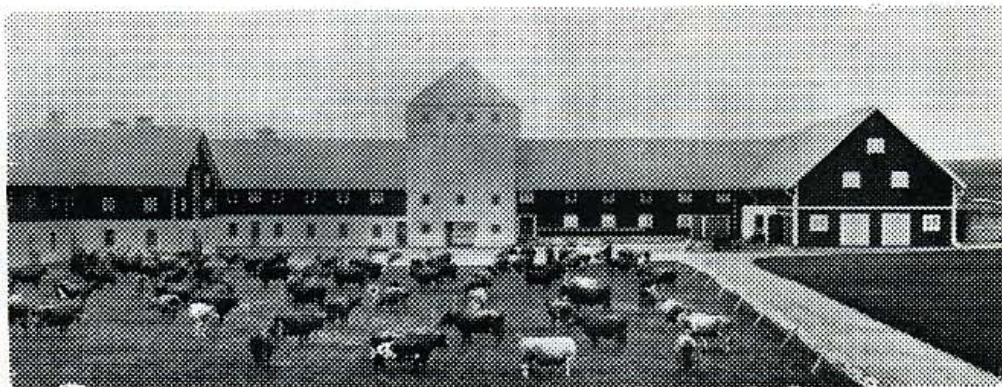
Opstad, fjøs, stall og kornsilo
